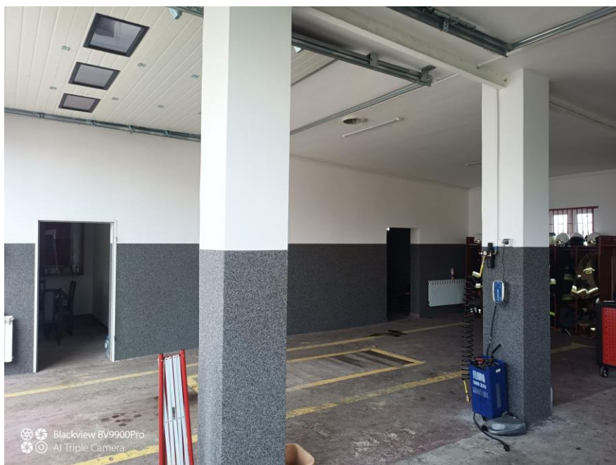
Remont pomieszczeń garażowych w remizie OSP Huta w ramach dotacji MSWiA oraz środków Urzędu Gminy Czarnków w prpoprcjach 5000,00 na 5000,00 zł
